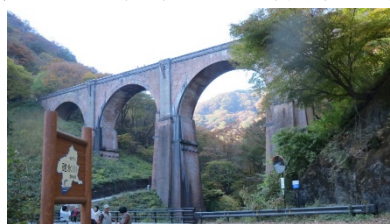
碓井峠・めがね橋
